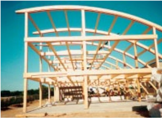
S. 10: Das in Schleswig-Holstein gebaute Einfamilienhaus von denker.denker.architekten zeichnet sich durch den integrierten Wintergarten und den einfallsreichen Grundriss aus. rechts und oben: Die modernen Typenhausentwürfe werden in Skelettbauweise realisiert. Ill.: de.de.
